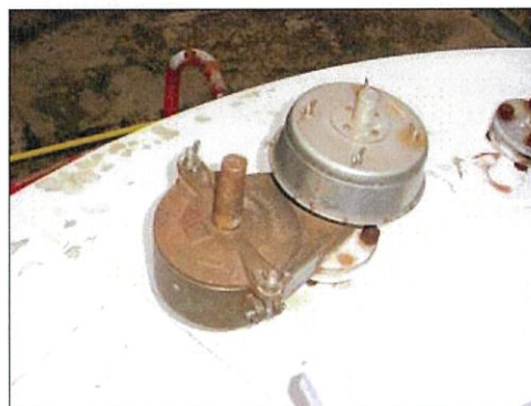
วาล์วระบายความดันและป้องกันการเกิดสุญญากาศ (Pressure-Vacuum Relief Valve) สำหรับถังเก็บสารเคมี
