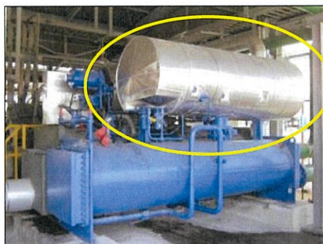
ภาพที่ 2.2-9 อุปกรณ์ลดเสียงจากแหล่งกำเนิด (บริเวณ MRU)
