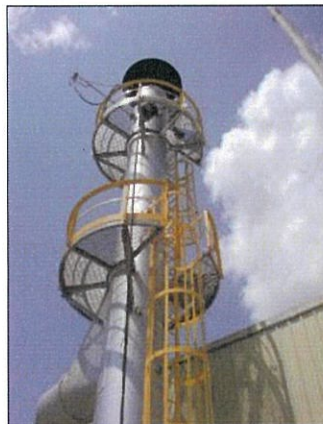
ภาพที่ 2.2-1 ปล่องหม้อไอน้ำ (Boiler)
